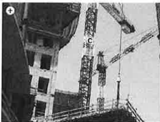
Un cantiere edile (Foto by Archivio2)
